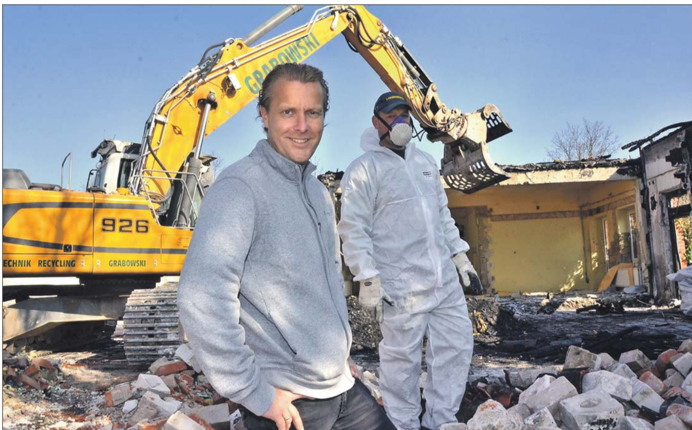
Der Abriss der abgebrannten Ladenzeile hat gerade begonnen. Abbruchunternehmer Dirk Grabowski (links) ist zuversichtlich, dass in drei Wochen alles geräumt ist. Heiko Fronder und Baggerfahrer Denis Erdmann schaffen ordentlich was weg. Fotos Cornelia Müller
