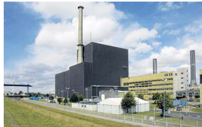
Das Atomkraftwerk Brunsbüttel ist – wie das in Krümmel – seit Jahren abgeschaltet. Beide sollen abgerissen werden. FOTO: DPA
